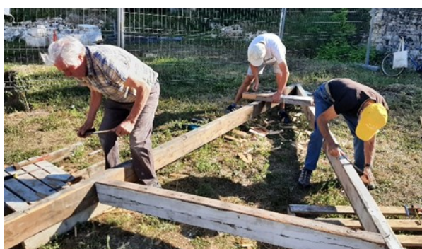
Fabrication d'une chèvre de levage
